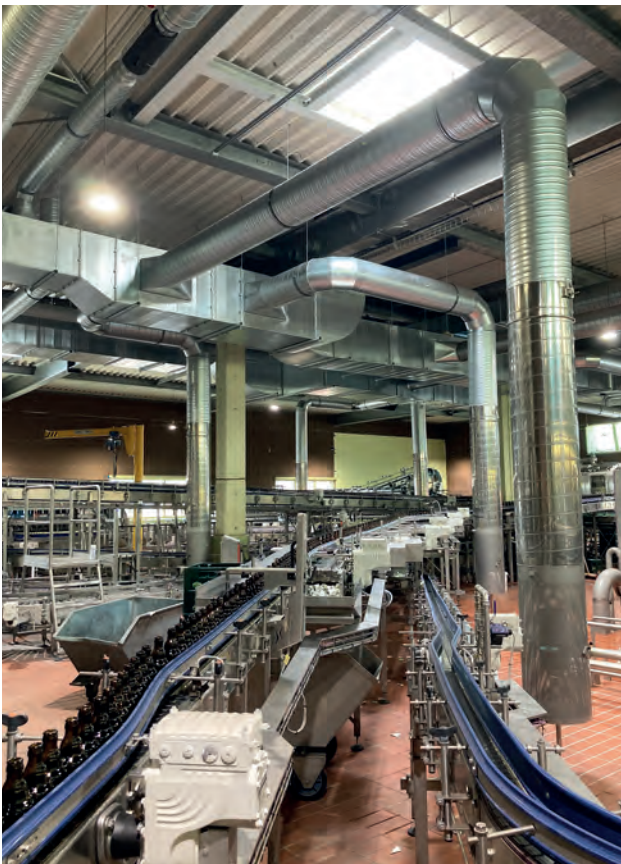
Dach und Decke des Abfüllgebäudes mit den beiden Abfüllanlagen für Flaschenbier wurden in 2021 komplett erneuert. Eine neue Lüftungsanlage sorgt mittels neuer Lüftungsrohre für gute Raumlufbedingungen.
